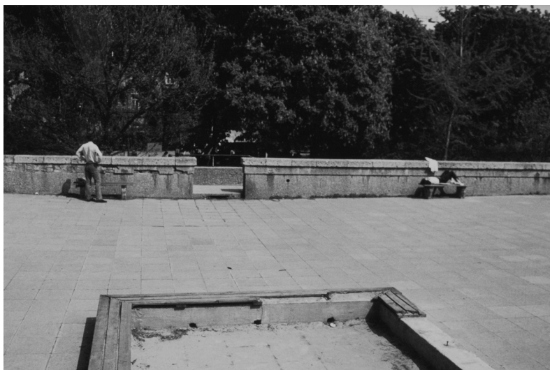
Abb. 5 Bunkerdach, 1984; pos/68487/o15 © Volkskundemuseum Wien
